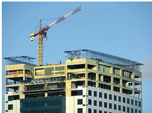
Edifício em construção
